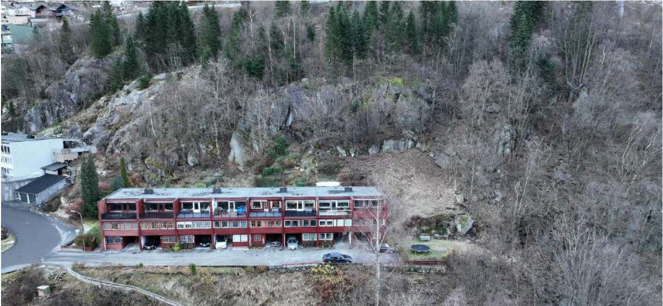
Figur 5-85: Bergskrent bak Ragdevegen 2-16 (partall). Det er observert boltesikring i skrenten.
