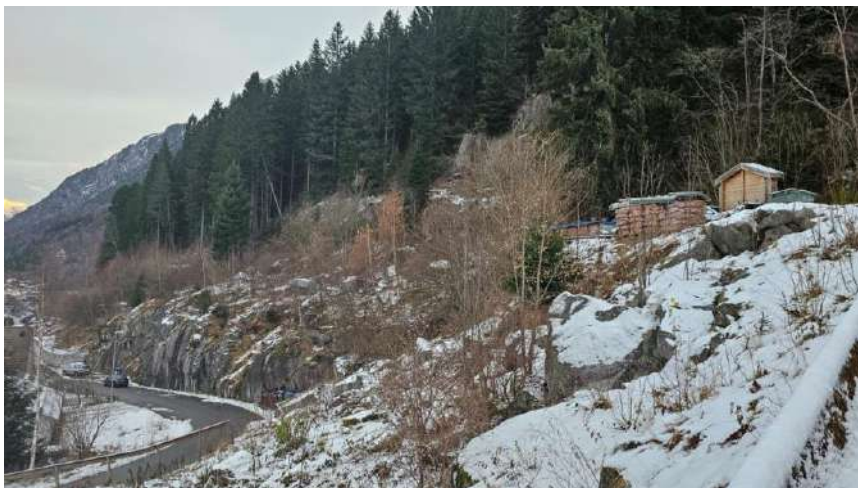
Figur 5-65: Foto ved infopunkt 8. Det ligger spredte blokker ovenfor skjærings langs Ragdevegen, både mot nord og sør i forhold til hvor bildet er tatt.
