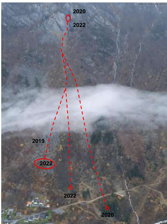
Figur 2-9: Oversiktsbilde over utløpet til steinskredet den 03.11.2022. Foto: Ullensvang kommune.
