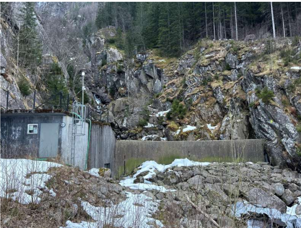
Figur 5-90: Demningen befart til fots.
