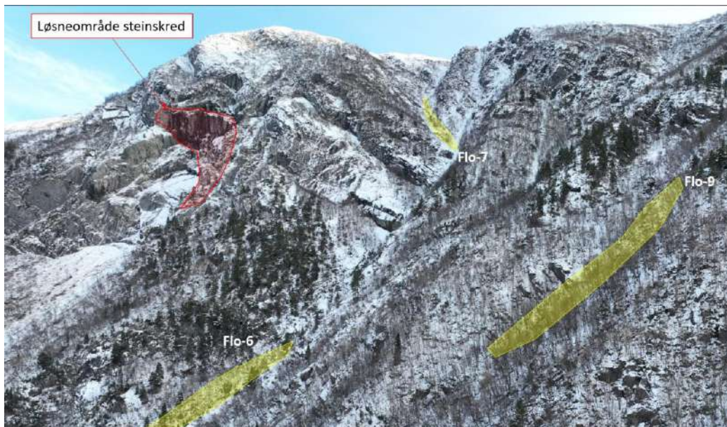
Figur 5-13: Oversiktsbilde over fjellsiden ovenfor Freim sett mot nord, som viser identifiserte løsnemråder for flomskred (gult) og steinskred (rødt).
