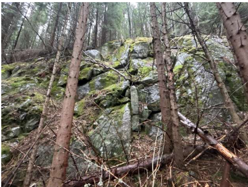
Figur 5-79: Oppsprukket bergmasse med ingen ferske nedfall nedenfor, ved infopunkt 158 (kote 320).
