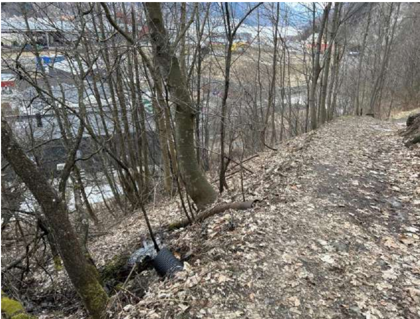
Figur 5-99: Vannveg som går gjennom løsmasseskråning ovenfor Hjøllovegen 28 og 30 (infopunkt 134).
