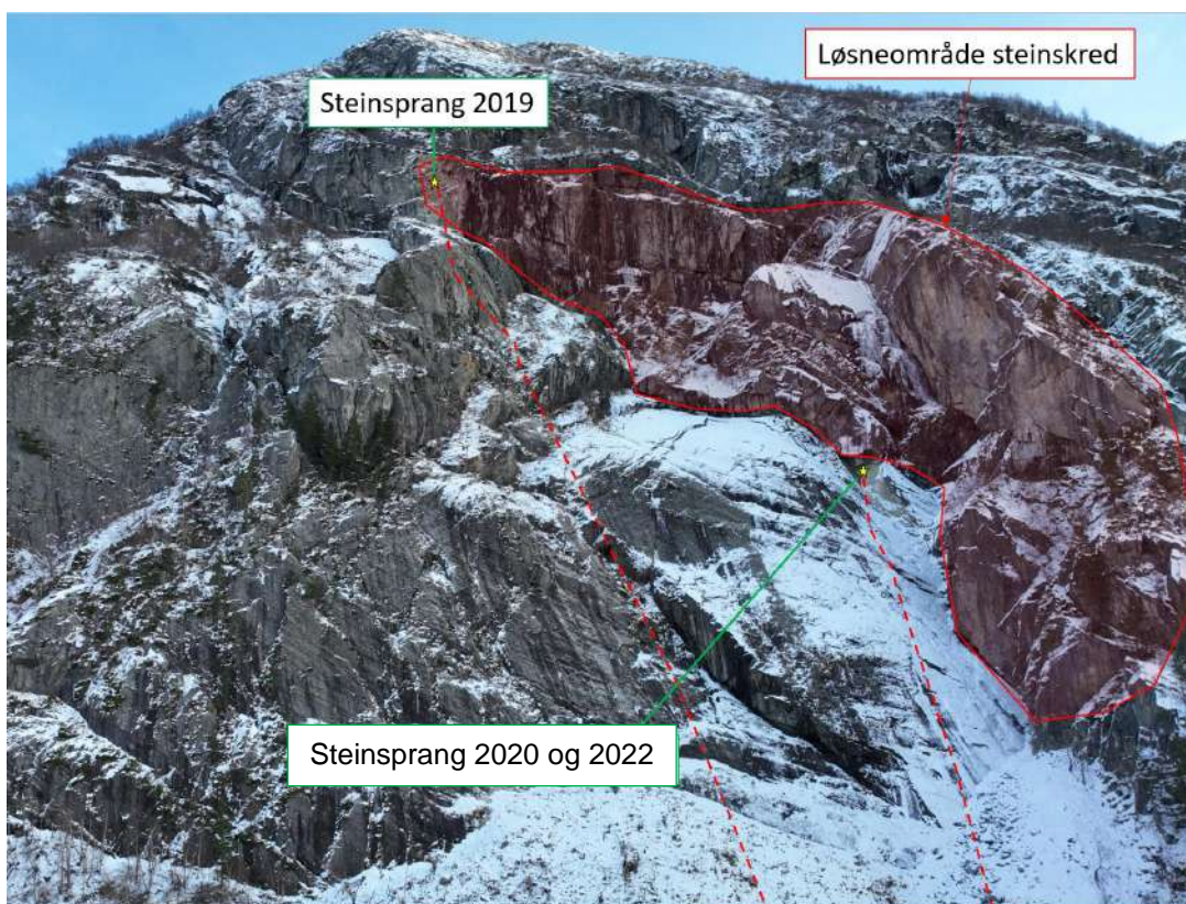
Figur 5-14: Nærbilde av fjellskrenten nedenfor punkt 1120 moh. og Slettbakksvaet. Bildet viser potensielle bergaprtier som kan være steinskredobjekter, samt løsnemrådet for steinspranget som gikk 03.07.2022 (markert med gul stjerne).
