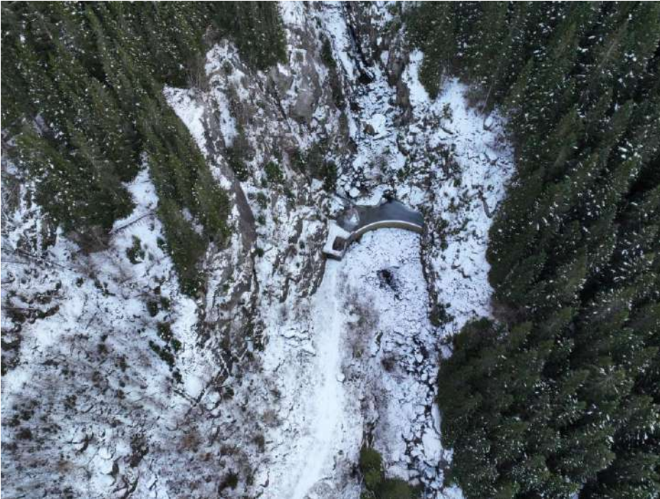
Figur 5-89: Nærbilde av demningen i Freimselva.
