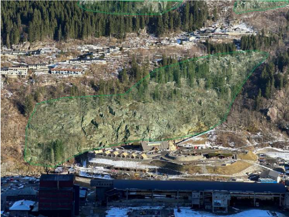
Figur 5-62: Løsneområde for steinsprang ovenfor Lothepus Camping og nedenfor Ragde (nedre skrentrekke).
