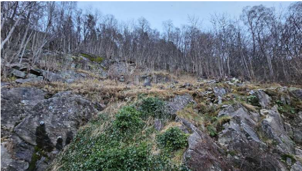
Figur 5-5: Infopunkt 75. Terrenget nedenfor Stp-1 med sporadiske blokker i fjellsida. Det ble observert boltede blokker oppe i fjellsida. Bergmassen er forholdsvis kompetent med hovedsakelig 3 sprekkesett og noe varierende sprekkeavstand. Noe kortere sprekkeavstand i Stp-1 sammenlignet med Stp-2 og Stp-3.
