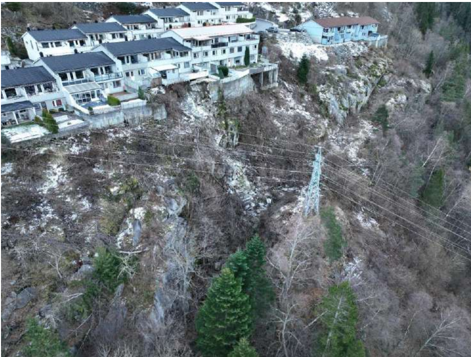
Figur 5-82: Foto av utglidningen som skjedde nedenfor Ragdevegen 68-70, i 1998 og 2021.
