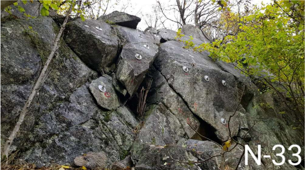
Figur 2-39: Eksempel på utført boltesikring ved lokalitet N-33.
