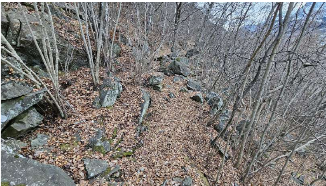
Figur 5-7: Foto ved infopunkt 71. Urmasser hvor enkelte blokker kan remobiliseres.
