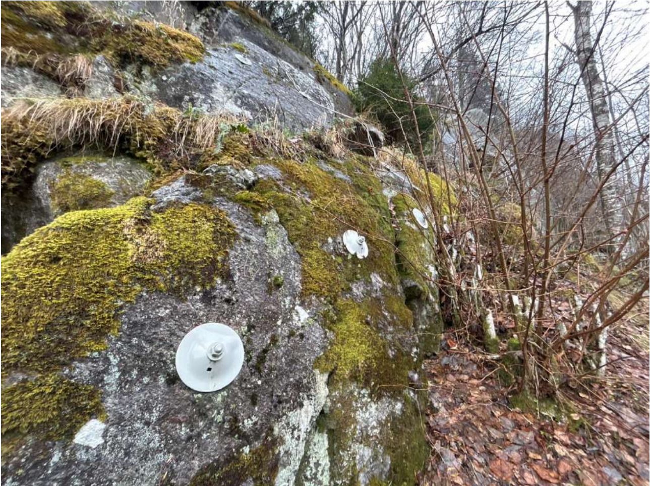
Figur 5-72: Boltesikret objekt ovenfor Ragdevegen 151 – 167.
