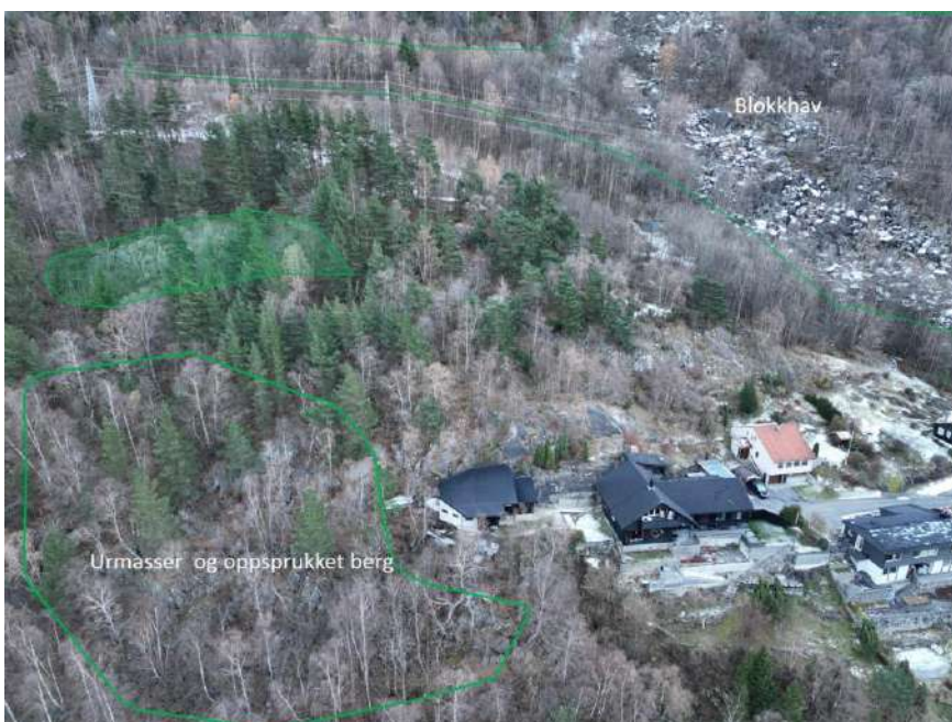
Figur 5-3: Fjellsiden ovenfor Skogen opp til mastetraséen, samt blokkhavet ovenfor Freim til høyre.
