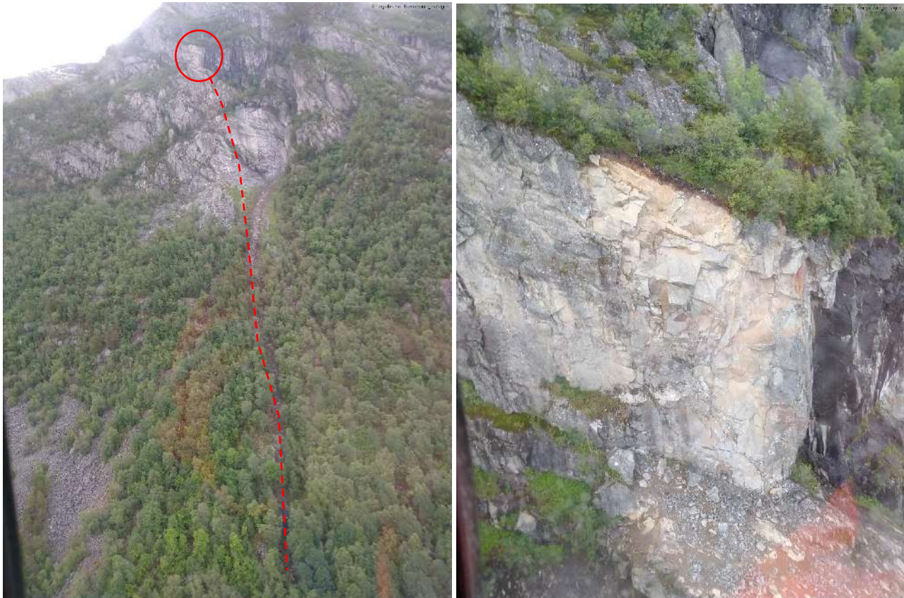
Figur 2-10: Løsneområdet og øvre utløp til steinspranghendelsen 25.06.2019. Foto: Ullensvang kommune.
