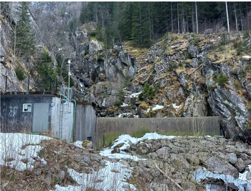
Figur 5-90: Demningen befart til fots.
