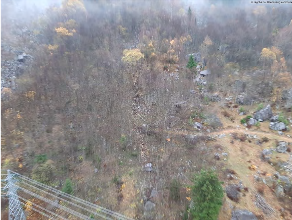
Figur 2-8: Bilde av steinskredet som gikk ned mot masttraséen 03.11.2022 [5].
