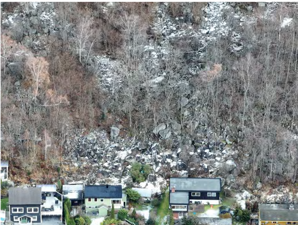
Figur 5-55: Urmasser tett inntil bebyggelse ved øverste husrekke av Freim.
