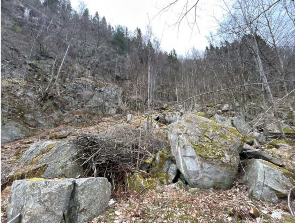
Figur 5-97: Urmasser, trolig fra et gammelt steinskred sør-øst for Lothepus camping (infopunkt 127). Det ble ikke observert ferske blokker.
