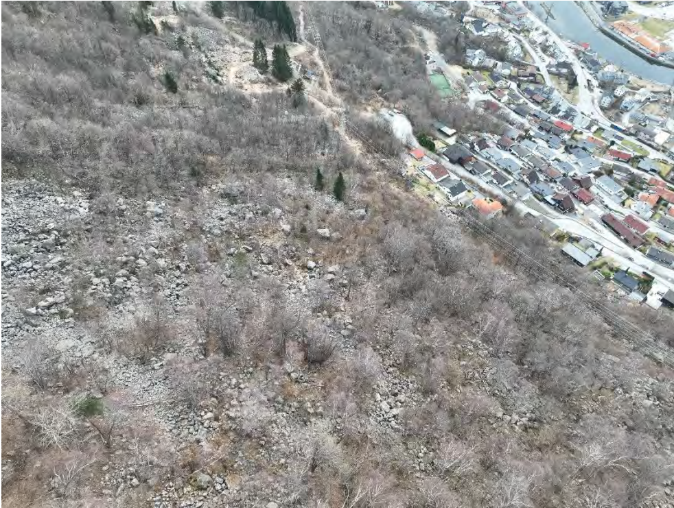
Figur 5-25: Dronefoto av rasura ved Mjølstølkvitlet, nederfor Slettbakksvaet.
