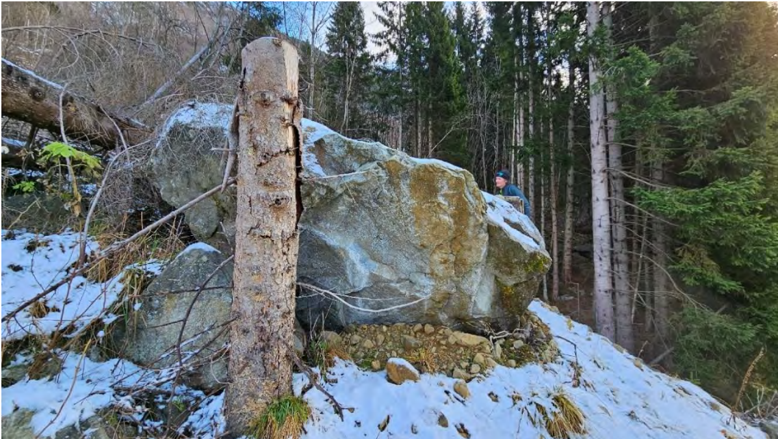
Figur 5-30: Steinsprangblokk observert mellom Freimsveien og mastetraséen ved infopunkt 38. Steinspranghendelsen skjedde 03.07.2020.
