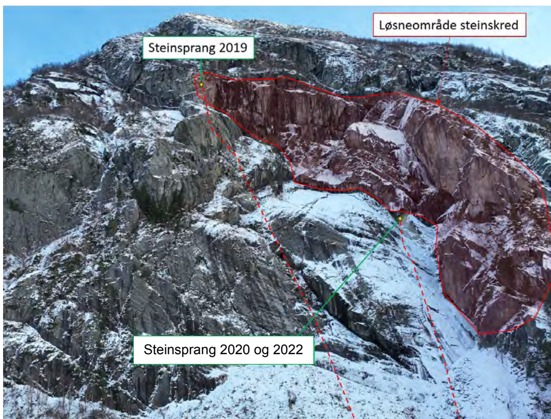
Figur 5-14: Nærbilde av fjellskrenten nedenfor punkt 1120 moh. og Slettbakksvaet. Bildet viser potensielle bergpartier som kan være steinskredobjekter, samt løsningsområdet for steinspranget som gikk 03.07.2022 (markert med gul stjerne).
