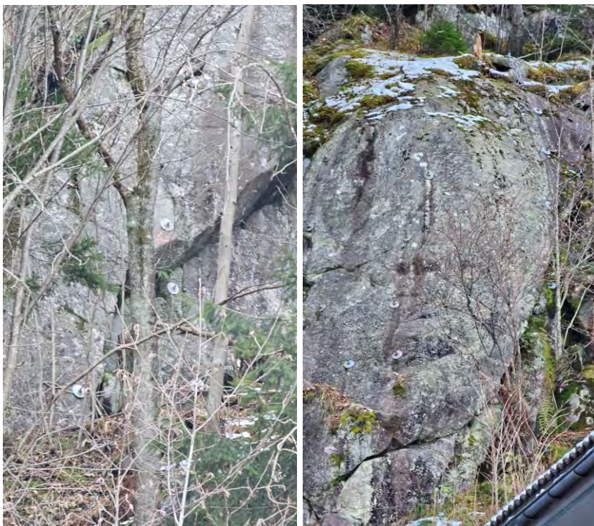
Figur 5-80: Spredt bolting i bergskrenter nært bebyggelse i søndre del av Ragde.
