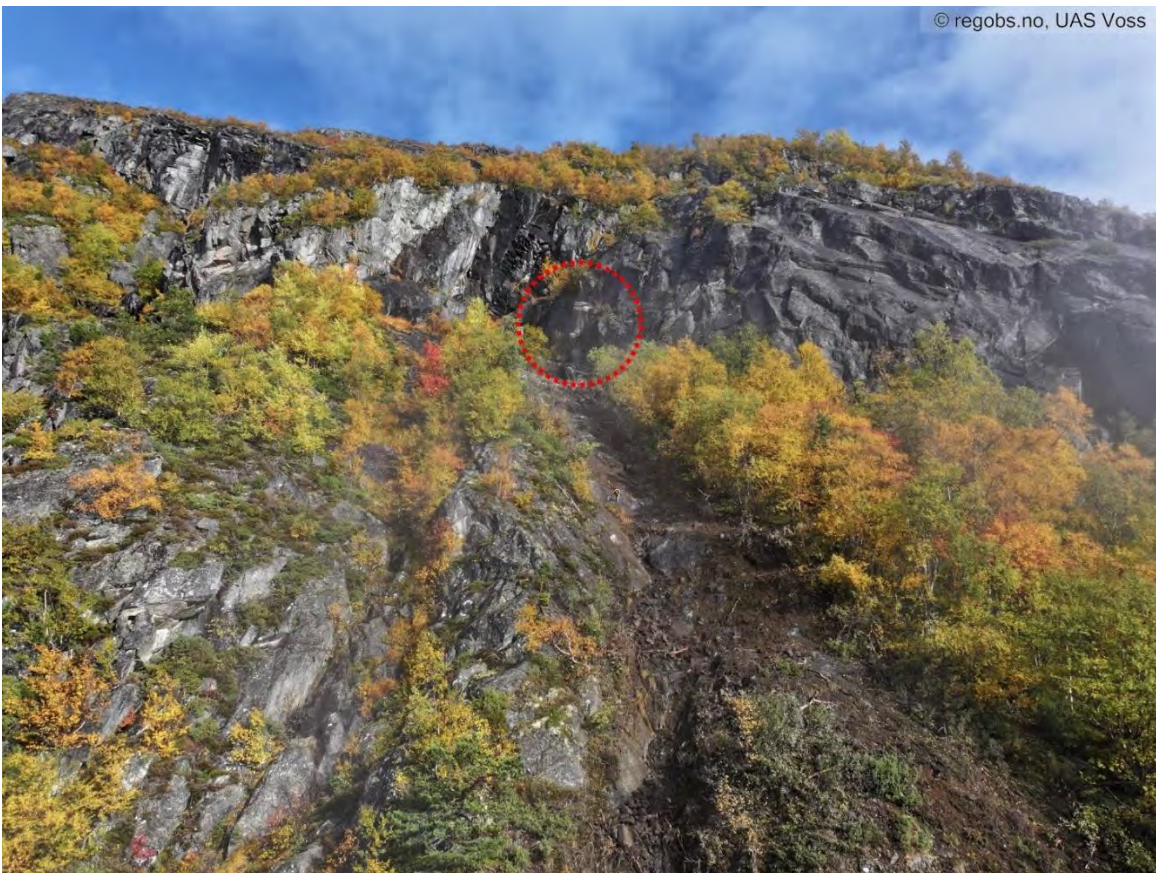
Figur 2-15: Løsneområdet til steinspranget 04.10.2023. Dronefoto tatt av UAS Voss.
