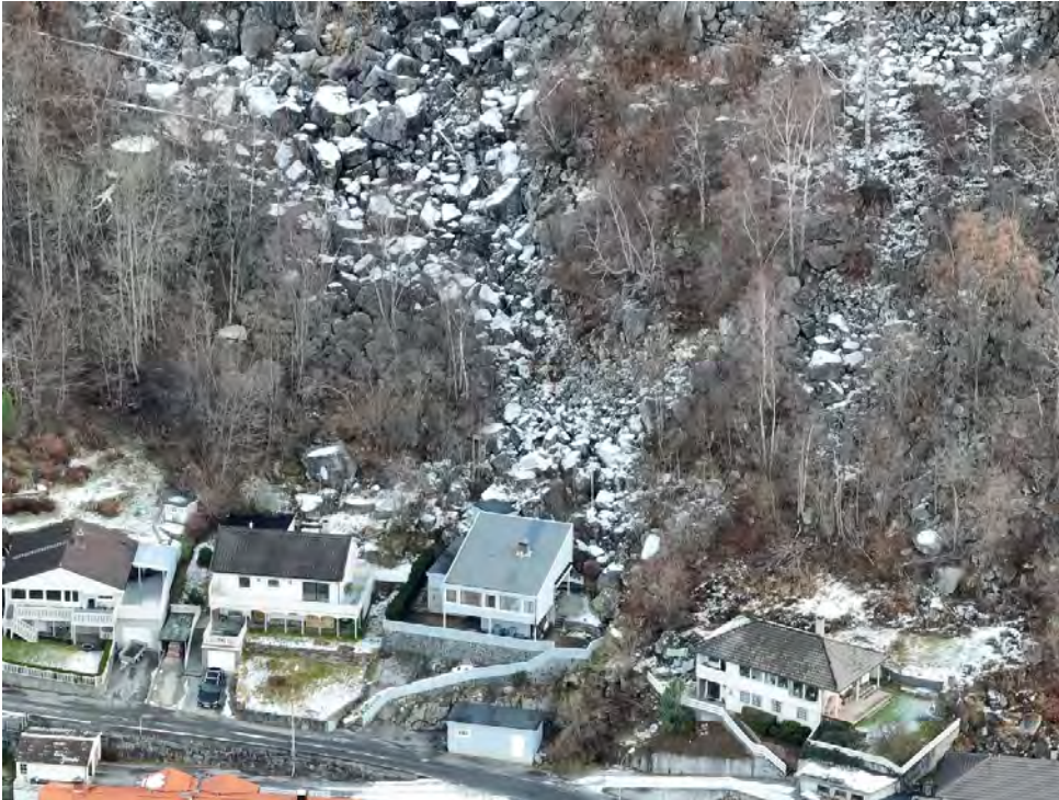
Figur 5-54: Nærbilde av ura tett inntil øvre husrekke på Freim.
