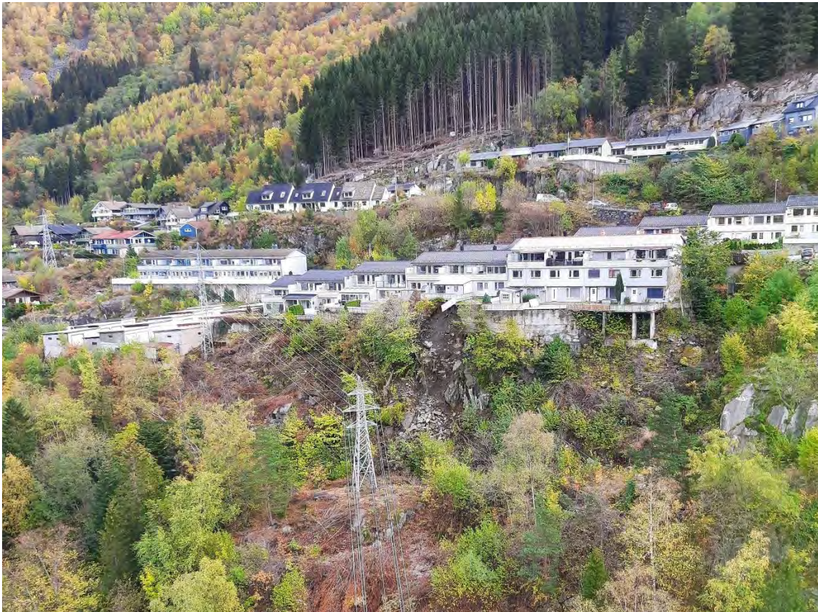
Figur 2-18: Utglidning den 16.oktober 2021, nedenfor boligbebyggelse på Ragde. Foto tatt av Ullensvang kommune.
