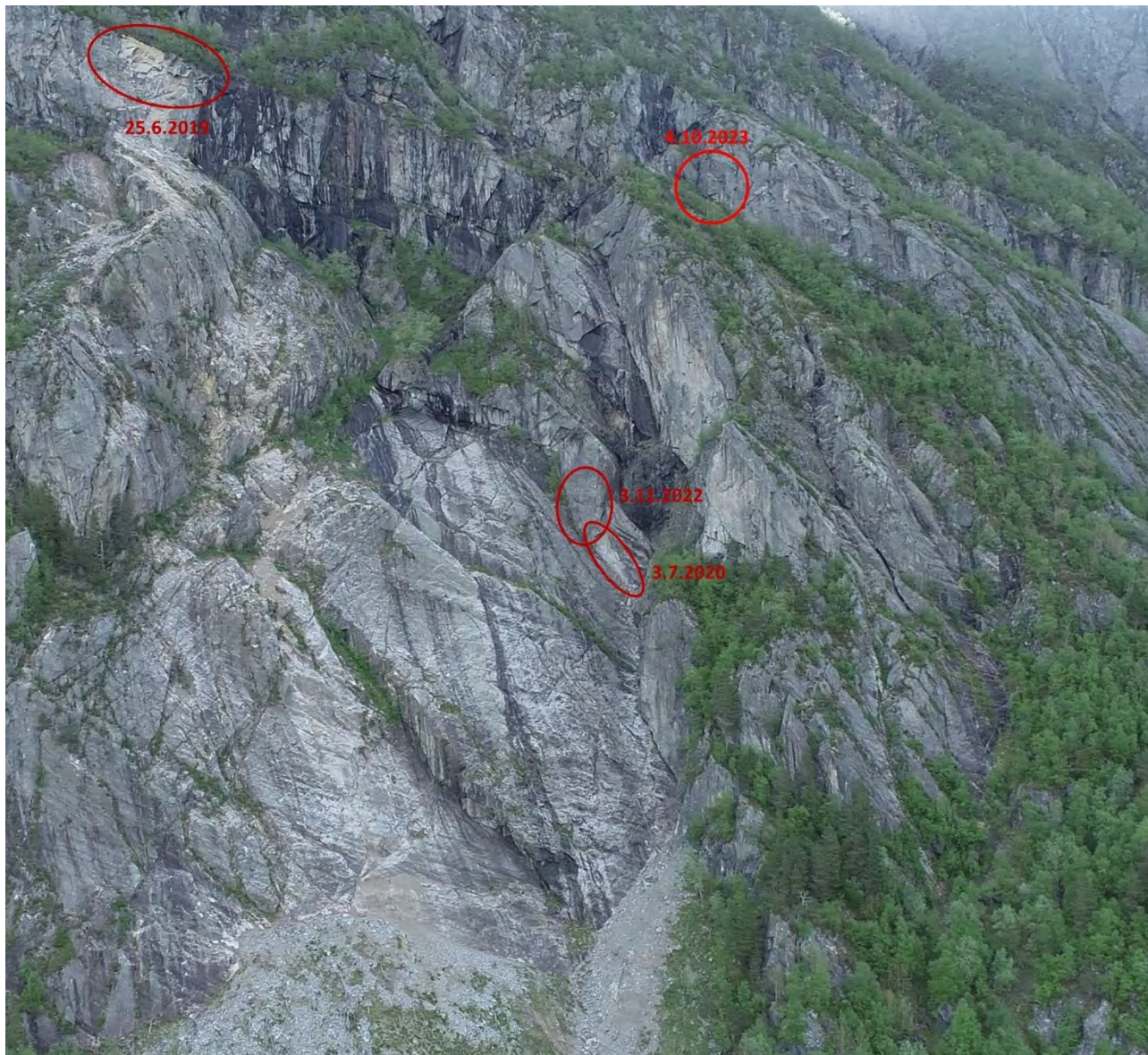
Figur 2-17: Oversiktsbilde over løснеområdene fra 2019, 2020, 2022 og 2023. Foto: Ullensvang kommune.
