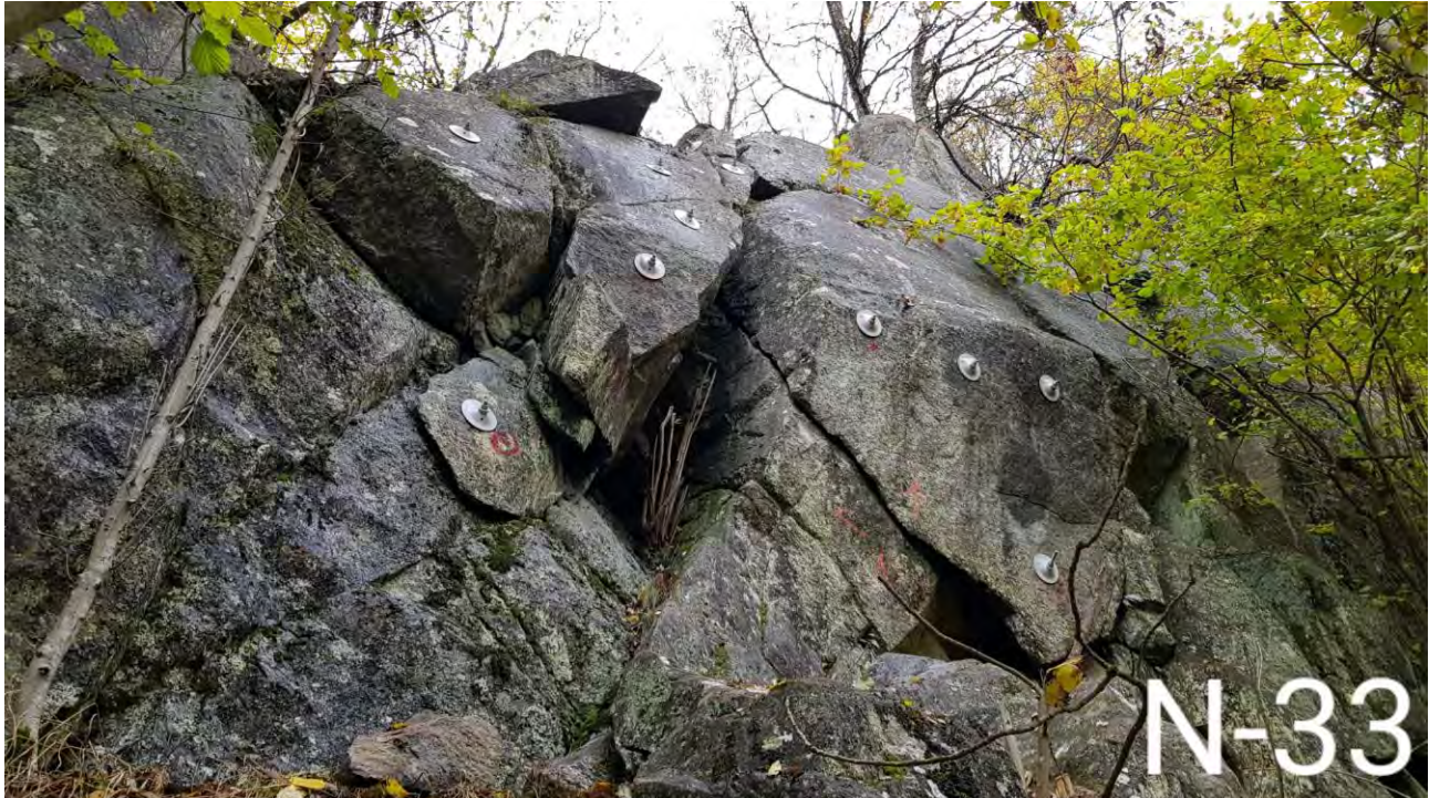
Figur 2-39: Eksempel på utført boltesikring ved lokalitet N-33.
