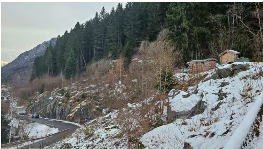
Figur 5-65: Foto ved infopunkt 8. Det ligger spredte blokker ovenfor skjærings langs Ragdevegen, både mot nord og sør i forhold til hvor bildet er tatt.
