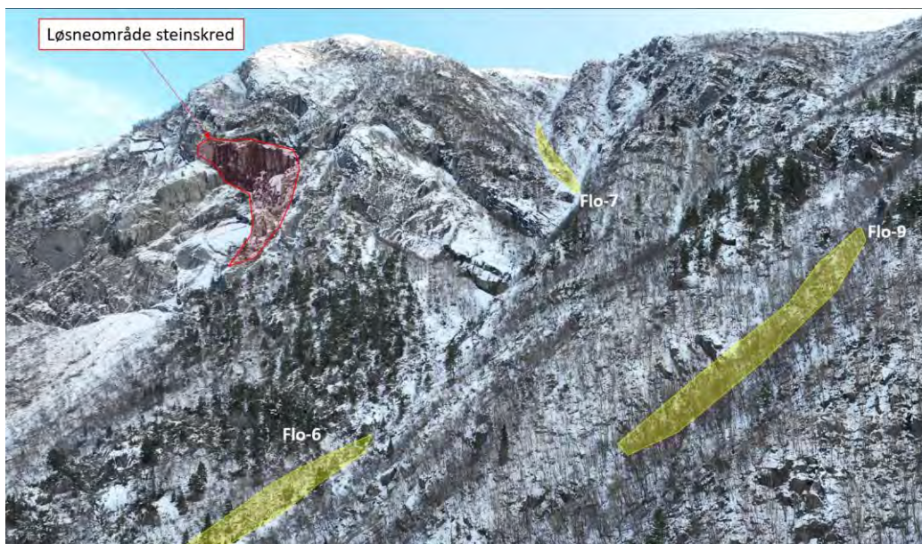
Figur 5-13: Oversiktsbilde over fjellsiden ovenfor Freim sett mot nord, som viser identifiserte løsningsområder for flomskred (gult) og steinskred (rødt).
