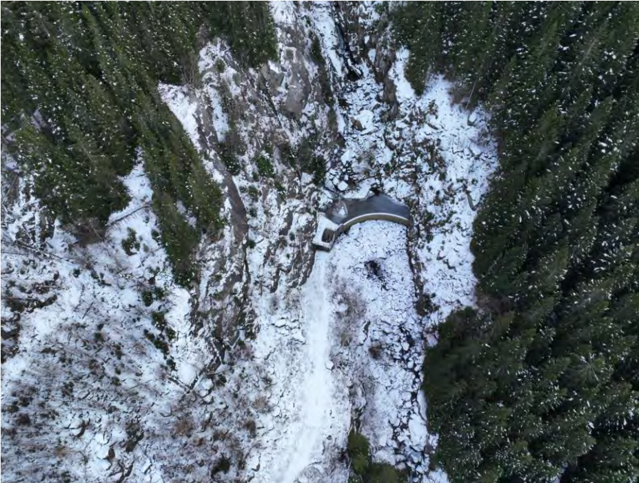
Figur 5-89: Nærbilde av demningen i Freimselva.
