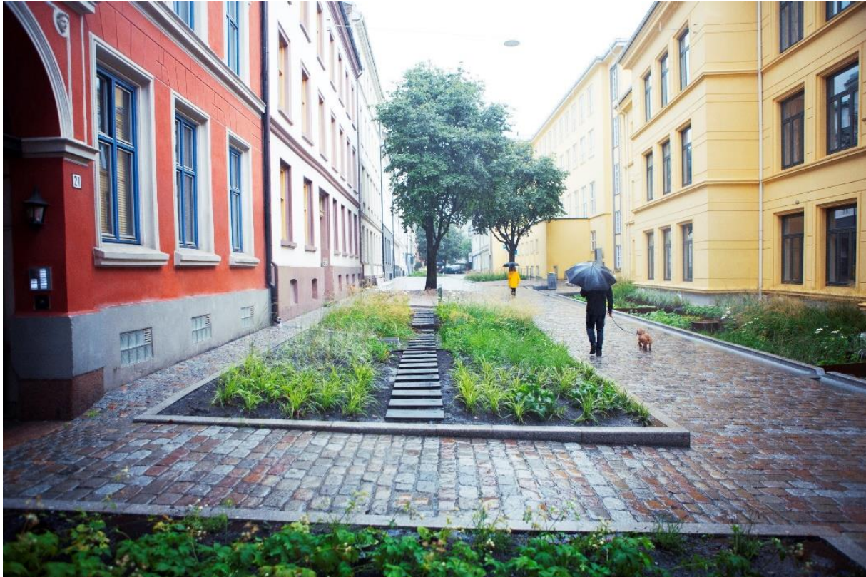
Figur 12: Regnbed i Deichmansgate bidrar til at mindre regn infiltreres, fordampes og forurenset avrenning renses (Foto: Åse Holte).
