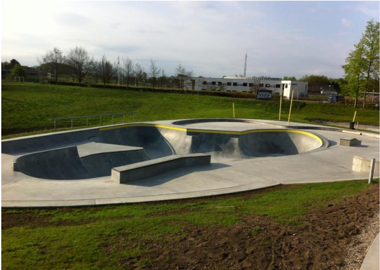
Figur 15: Rabalder skatepark i Roskilde fungerer som åpent fordrøyningsmagasin ved ekstremvær er representerer tiltak med flerbruk av arealer (foto: Søren N. Enevolden, Sne Architects og Rune Johansen).
