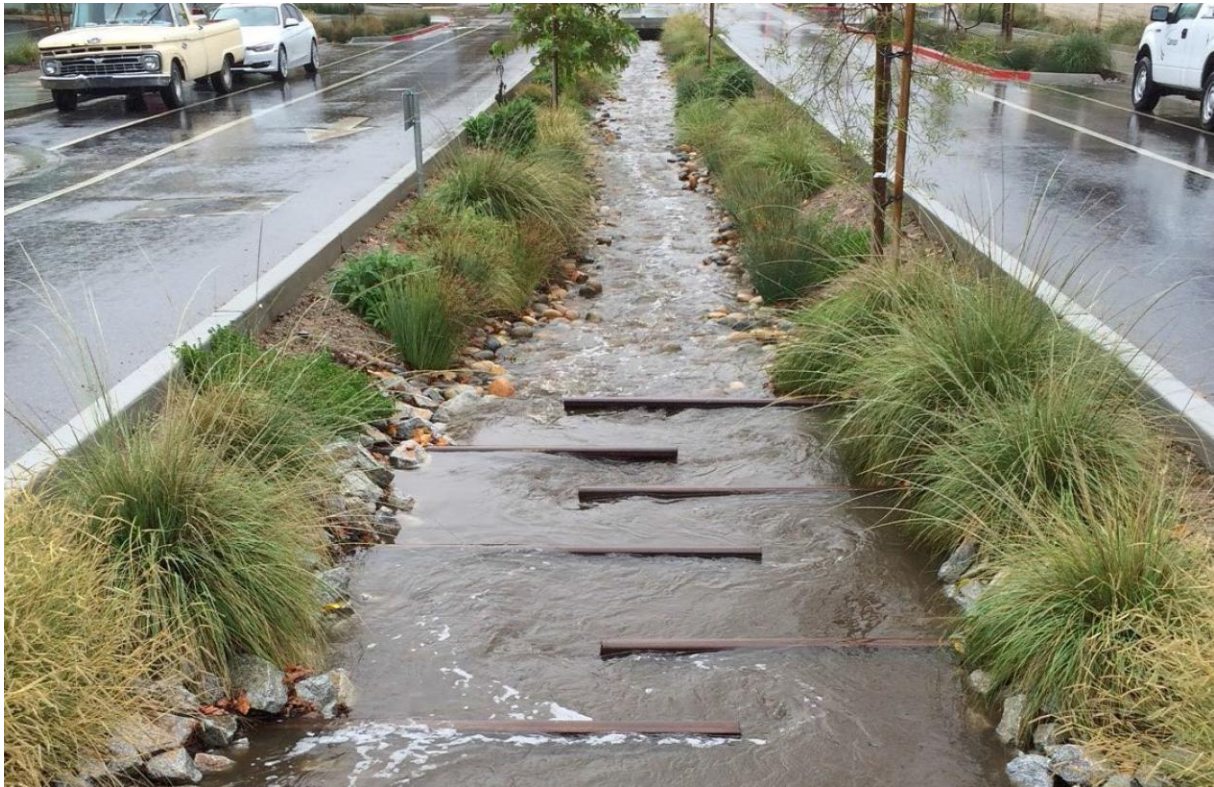
Figur 17: Eksempel på flomvei mellom veier.
