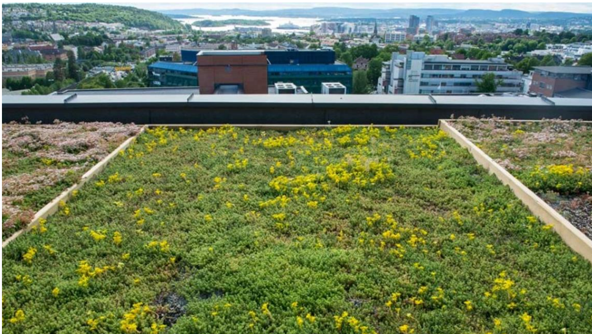
Figur 11: Grønne tak med liten vekstdybde bidrar til at mindre regn fanges opp og fordampes (Foto: Bård Bredesen / Naturarkivet).
