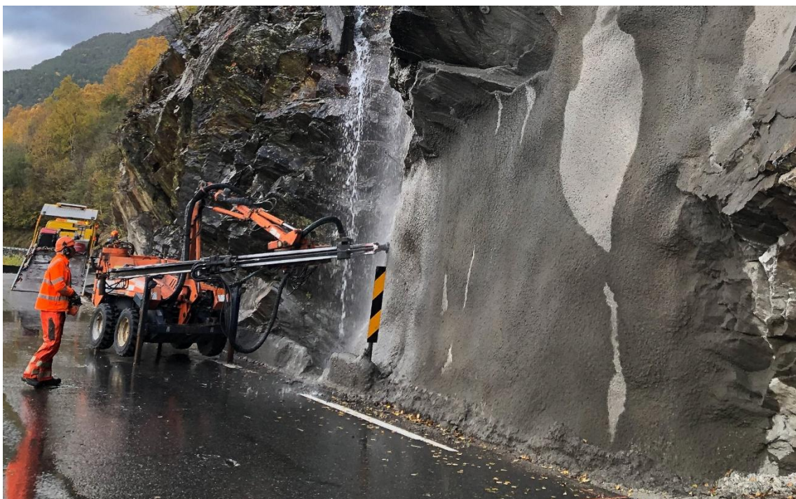
Figur 24: Sikring av fjell på rv.13 ved Skarvabjörgstunnelen.
