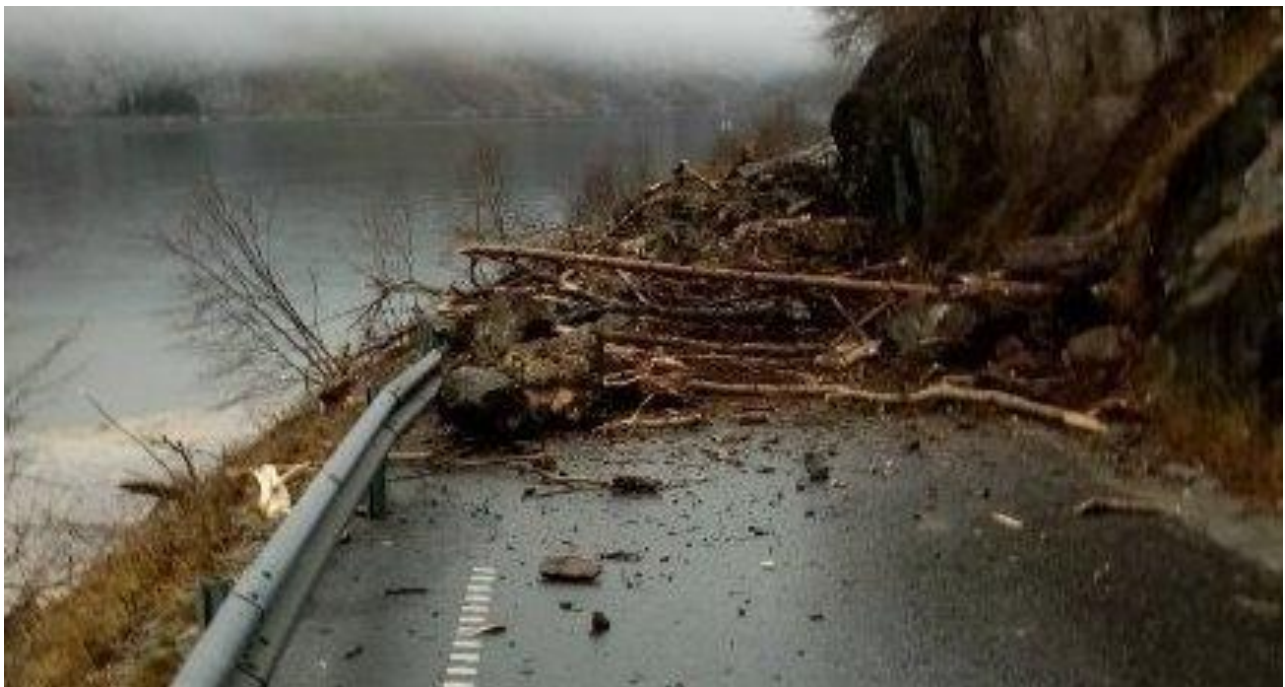
Figur 29: Ras på fv.49 mellom Austrepollen og Nordrepollen. Foto: Hardanger Folkeblad.
