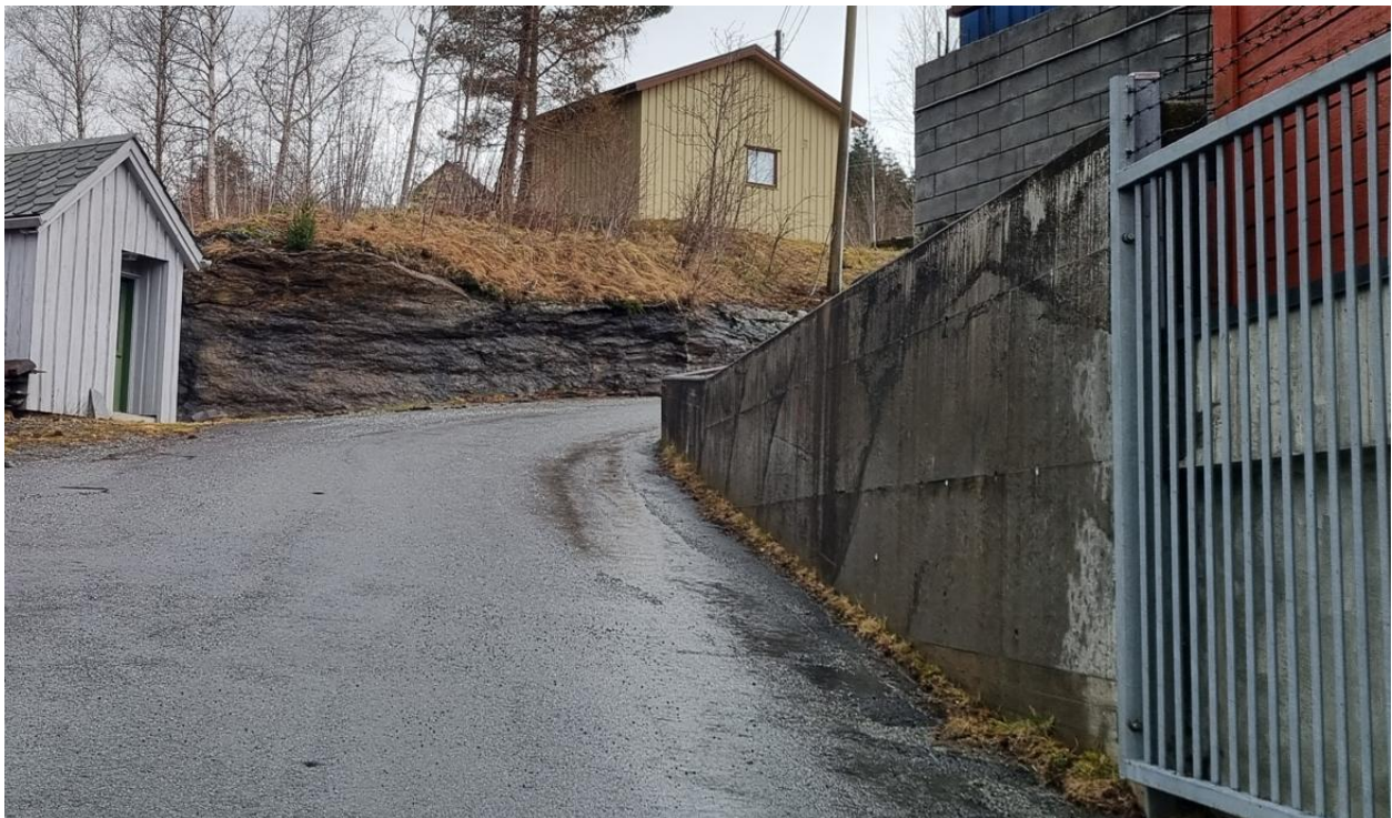
Figur 11 - Synleg fjell langs nedkøyringa til kaien til Mowi
