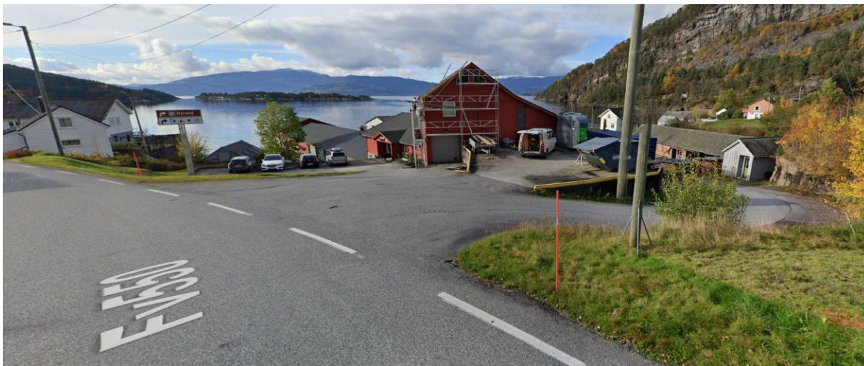
Figur 9 – Gatebilde av dagens vegtilkomst til settefiskanlegget, kjelde: google.no/maps .
