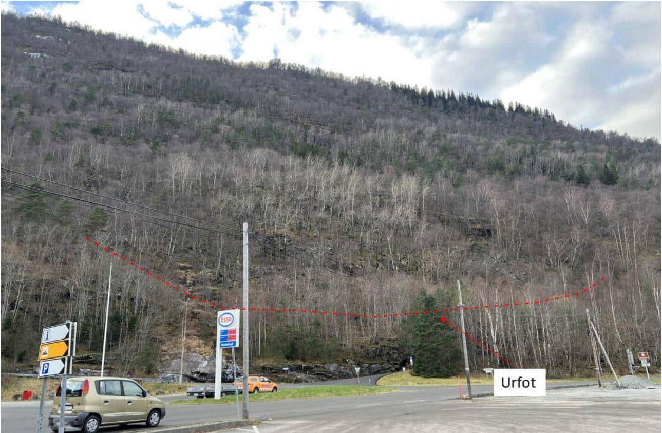
Figur 33 – Viser omtrentlig urfot i forhold til Rv. 13 og bensinstasjon.
