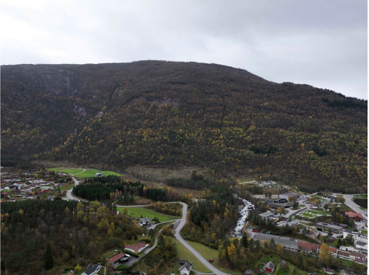
Figur 29 – Dronefoto som viser det vestlige påvirkningsområdet. I venstre del av bilde er det observert forholdsvis stor grad av erosjon, som er i den sørlige delen av påvirkningsområdet. I det sørlige området er det registrert løseområder for jordskred. Det er også noe erosjon i nordlige deler, samt enkelte løseområder for steinsprang.
